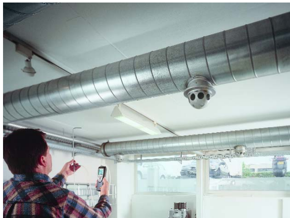
Измерения скорости воздуха в воздуховодах
